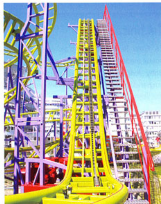
◀ Le lift et son moteur permettant de tracter les trains au sommet du parcours ▼
